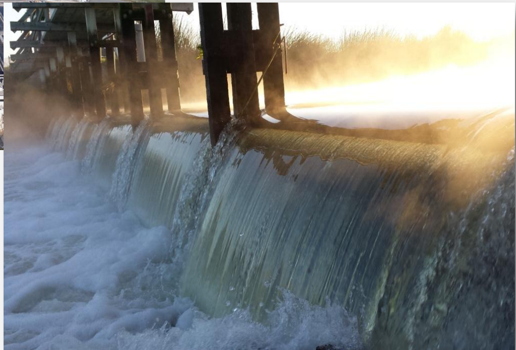
Effluent Discharge Outfall
